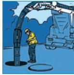
2 Creusement par aspiration sur prise d'eau
