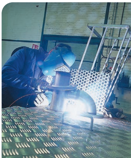
L'atelier de chaudronnerie
