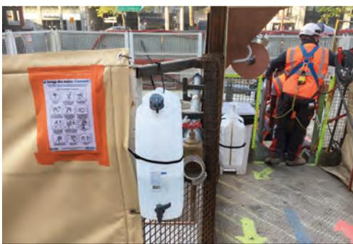
Point de lavage des mains en tête de puits et sens de circulation sur le chantier Eole
