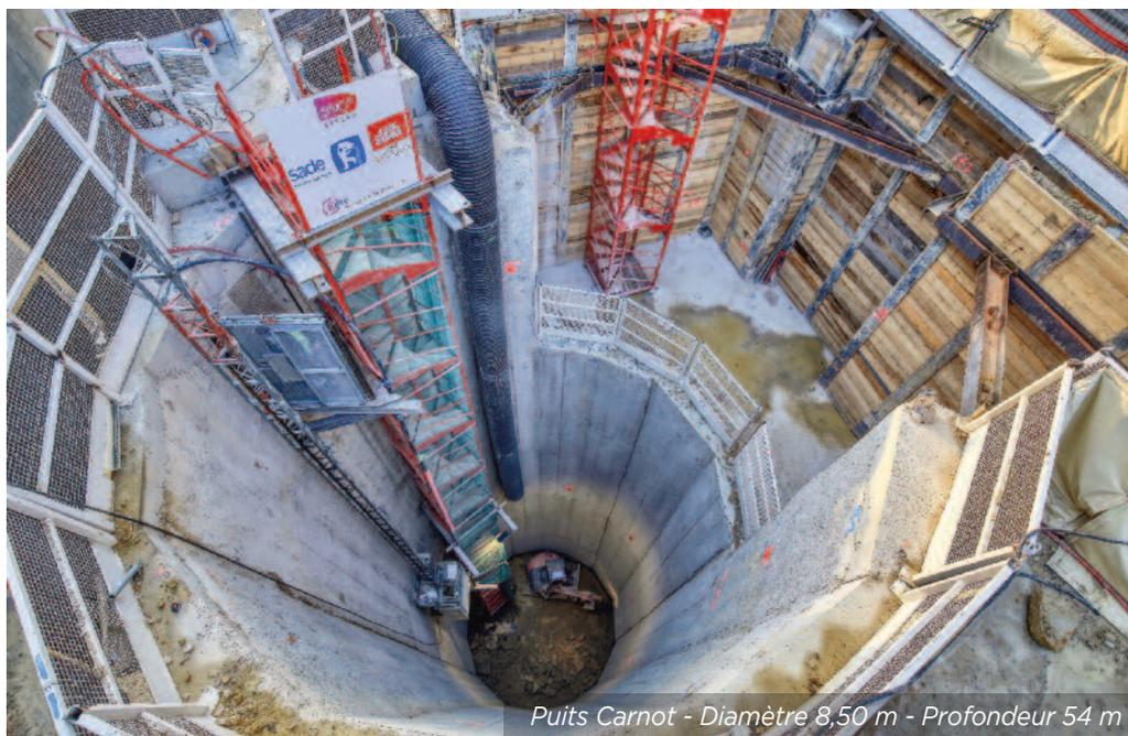
Puits Carnot - Diamètre 8,50 m - Profondeur 54 m
