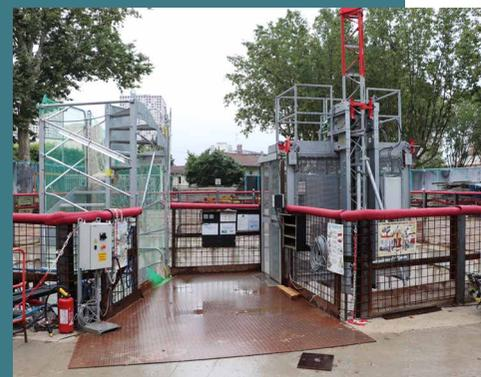
Après concertation avec la CRAMIF, les puits ont été équipés d'un ascenseur, jusqu'à 10 m au-dessus du fond de fouille, relié à la tour Escalib pour rejoindre le fond de l'ouvrage afin de se prémunir du risque d'inondation.
