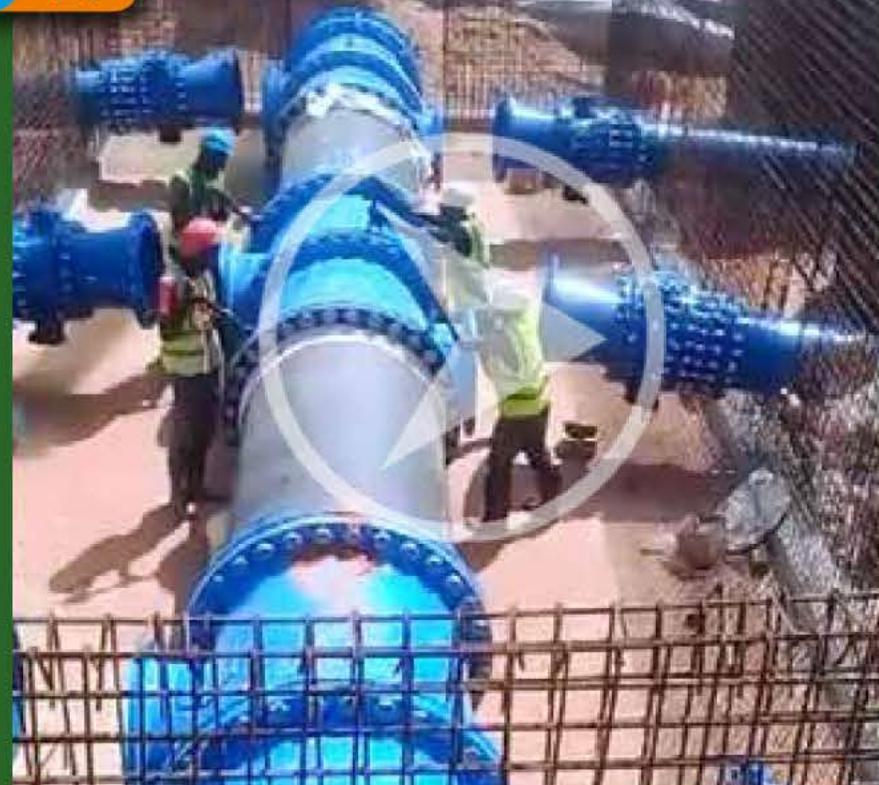
La SADE Sénégal a réalisé les travaux de renforcement de la protection antibélier de l'usine de traitement de Keur Momar Sarr (KMS) qui alimente Dakar : remplacement de 6 ballons antibélier de 50 m<sup>3</sup> chacun, fourniture et pose de conduites en fonte sur 300 m, construction de massifs en béton armé, et installation d'un système de télégestion et d'instrumentation.
